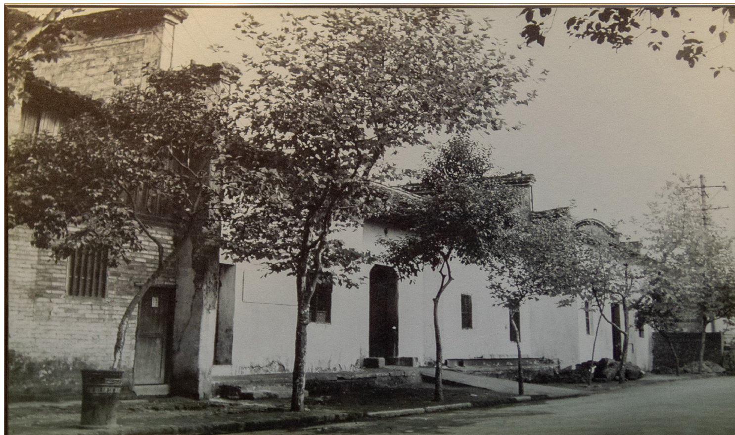
毛泽东十分重视工农武装。在醴陵县城考察农民运动期间，曾到醴陵县总工会考察工人武装情况。图为醴陵县总工会旧址——县城节孝祠。
